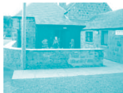
Boyndie Visitor Centre.
